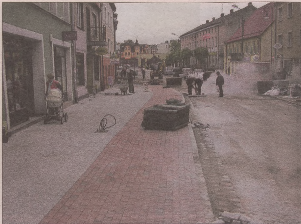
Prace przy przebudowie ulicy Wojska Polskiego potrwają do 15 czerwca.
