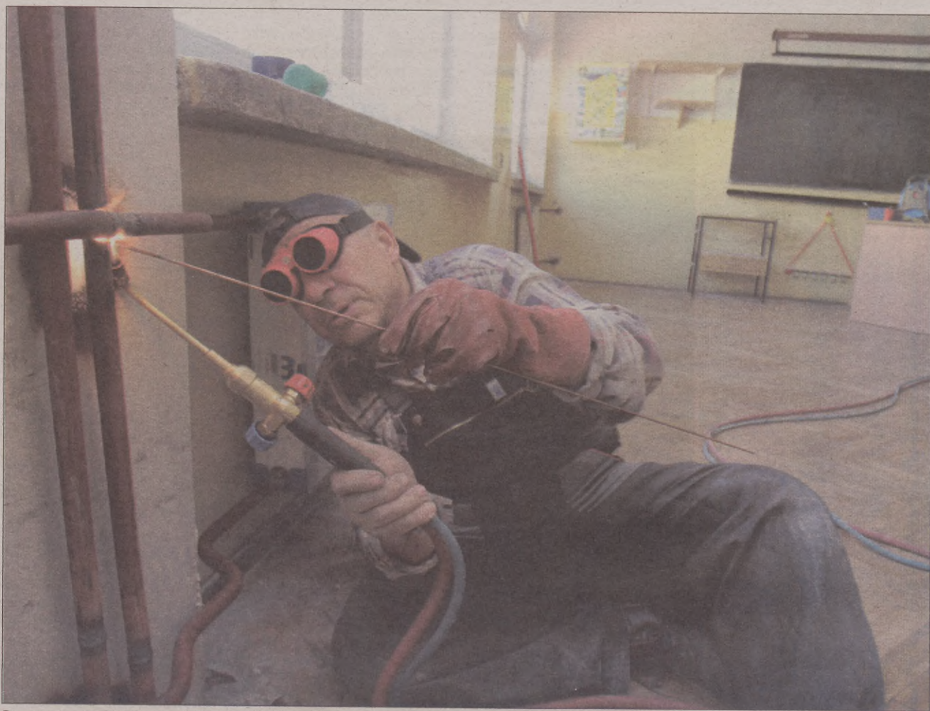
Remont w usteckiej dwójce wciąż trwa. Władysław Kantarski, starszy spawacz, przygotowuje do spawania rury centralnego ogrzewania. Fot. Łukasz Capar
