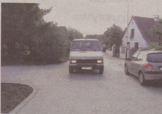
Nowa nawierzchnia ulicy.
