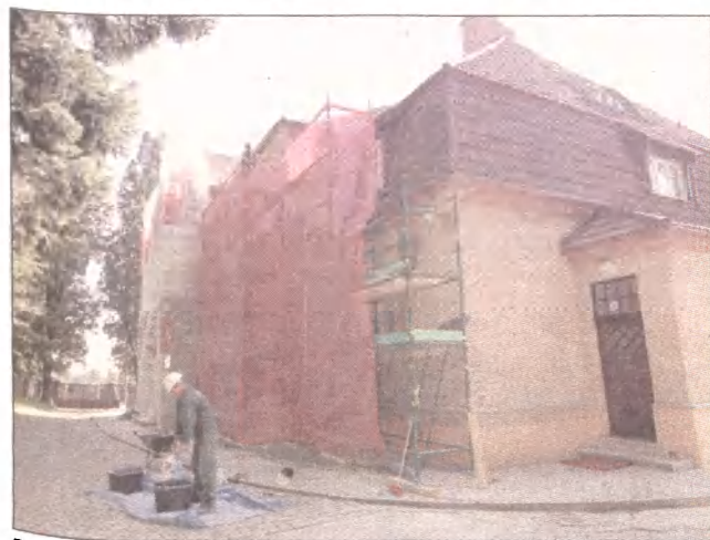
Remont zabytkowej willi odbywa się pod okiem konserwatora zabytków.
