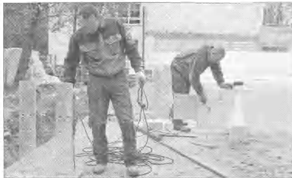
Trwa budowa hali sportowej przy ul. Zygmunta Augusta.
