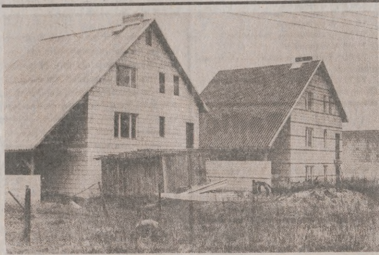
Dwuspadowe dachy wróciły do las w wiejskim budownictwie. Przykładem niech będzie osiedle domków we wsi Bydolino w woj. słupskim. (kar)
