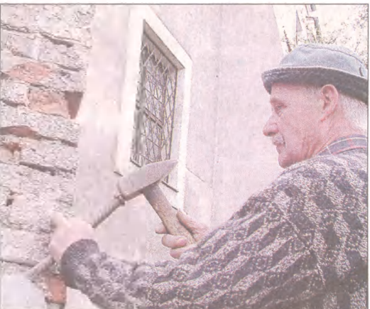
Na zdjęciu: Wczoraj rozpoczęły się prace przy renowacji przypór zamkowych Fot. Krzysztof Tomasiak
