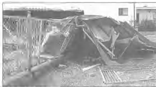
Na zdjęciu: Zerwany dach zdawałwał część plotu i bramę wjazdową. Fot. Grzegorz Janowczyk
