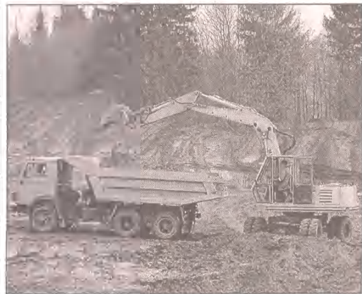
Bytowski „Drutex” rozpoczął przy ulicy Łęborskiej prace ziemne niezbędne przy budowie nowej hali produkcyjnej (na zdjęciu). Nowy zakład będzie wielkością boiska sportowego. Inwestycja podzielona na dwa etapy. Pierwsza część ma być gotowa w lipcu tego roku. Nowa hala oznacza nowe miejsca pracy. Leszek Głerszewski , współwłaściciel „Drutexu” mówi, że może to być nawet 200 osób. Uczestnicy w ciągu 2-3 lat planują zainwestować w firmę około 30 milionów złotych. „Drutex” jest krajowym liderem w produkcji okien PCV. (ang)
