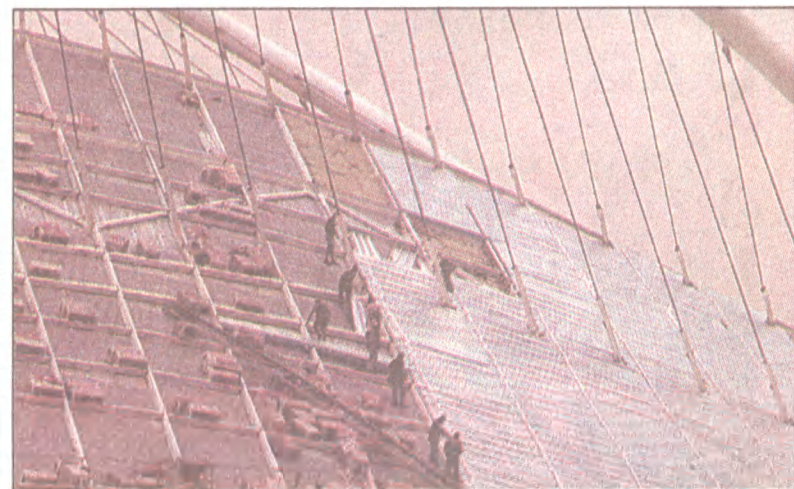
Na zdjęciu: Na 100 dni przed rozpoczęciem letnich igrzysk robotnicy układają na konstrukcji Stadionu Olimpijskiego szklane i metalowe elementy, z których będzie się składało pokrycie dachu. Fot. PAP
