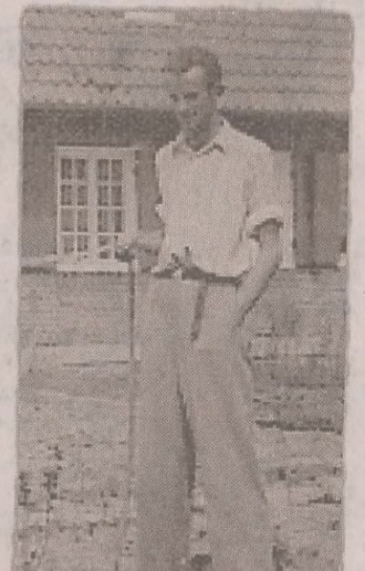
Inż. Trójger na początku wojny nadzorował prace przy budowie autostrady.
