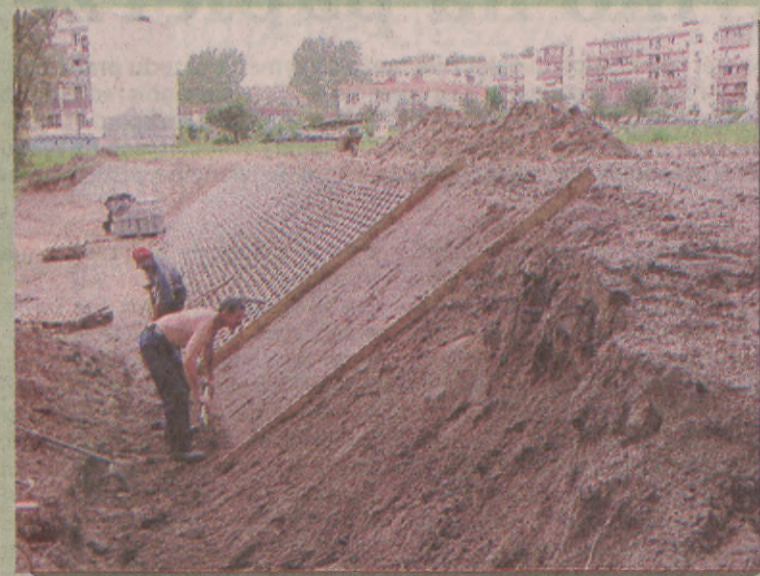
Szczecińska spółka, która kupiła działkę przy ulicy Długiej w Miastku, przygotowuje teren pod budowę marketu. Wzmacniane są skarpy i porządkowany teren. Budowę sklepu planuje się w przyszłym roku. Na zatrudnienie może liczyć kilkanaście osób. (ang)
