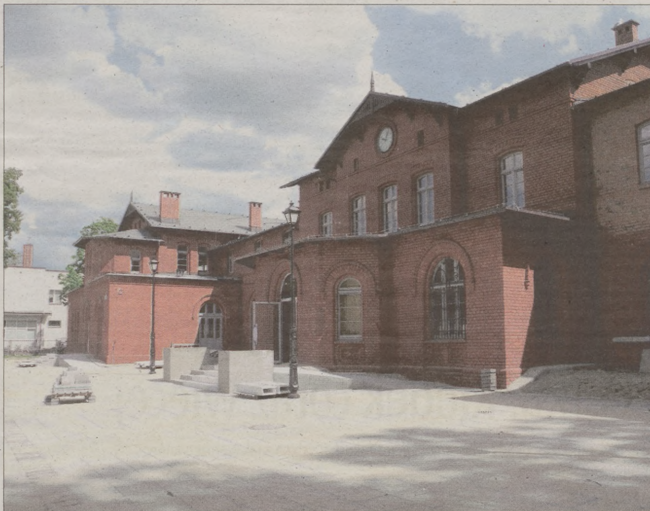
Remont lęborskiego dworca trwa od ubiegłego roku.
