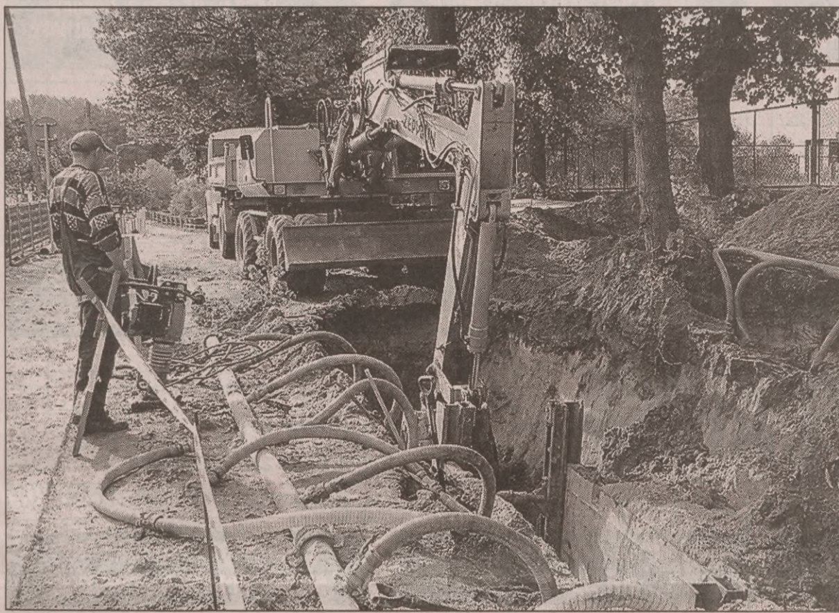
Firma „Eko-Instal” ze Studzienic buduje kanalizację przy ulicy Zielonej i Szkolnej w Miastku. Prace zakończą się za miesiąc. Wtedy mieszkańcy będą mogli podłączyć swoje
