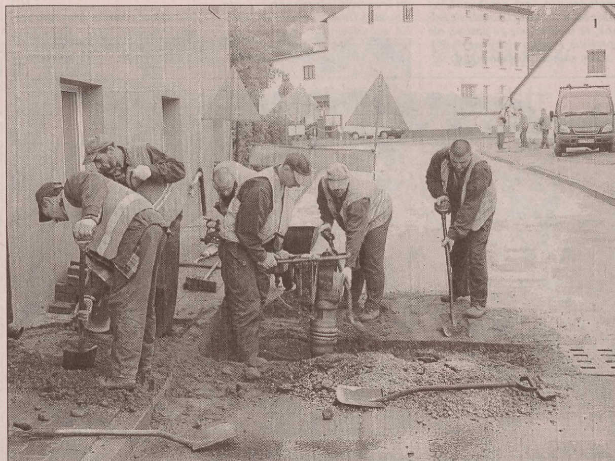
Słupska firma „Enbud” kładzie nowy kabel energetyczny przy ulicy Podzamcze i Młyńskiej w Bytowie. Wymianiane jest pół kilometra starych zniszczonych przewodów. Koszt prac wynosi 100 tysięcy złotych. (ang) Fot. Andrzej Gurba
