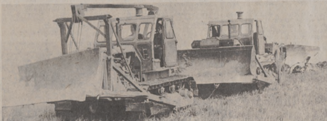
Jednym z warunków zwiększenia produktywności rolnictwa w naszym regionie jest przeprowadzenie na znacznych obszarach prac melioracyjnych i rekultywacyjnych. Aby to osiągnąć potrzebne są znaczne środki finansowe i dużo specjalistycznego sprzętu. Tymczasem i jednego i drugiego nam ciągle brakuje...
