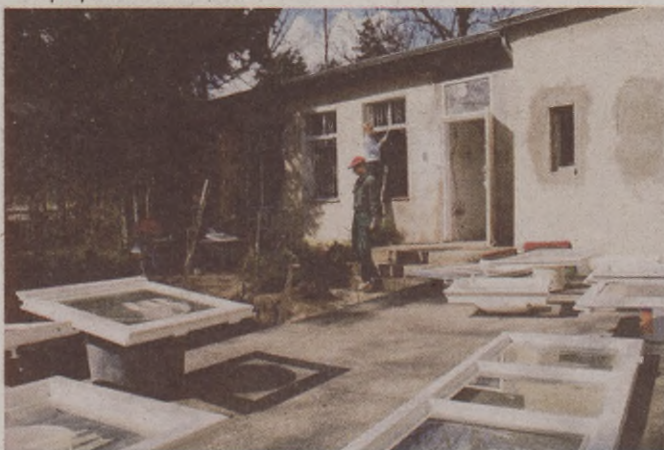
Ośrodek przed remontem.
