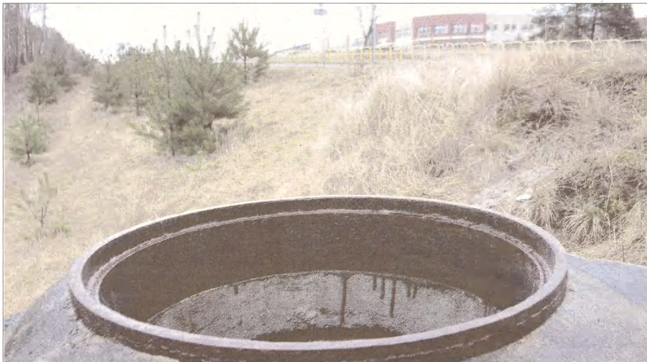
Odkryte i przez to niebezpieczne studnie niedaleko miastecckiego gimnazjum.
