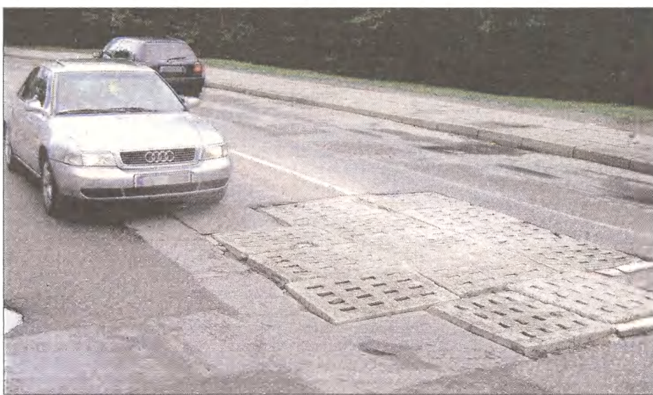
W tym roku na ulicy Koszalińskiej w Miastku zostanie wylany nowy dywanik asfaltowy.
