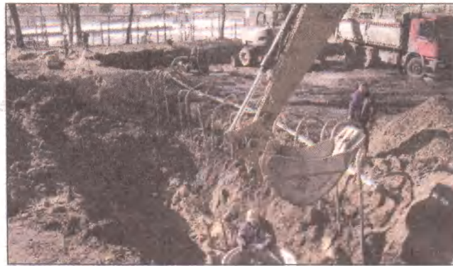
Pierwsze prace przy budowie basenu na terenie Miejskiego Ośrodka Sportu i Rekreacji w Bytowie.
