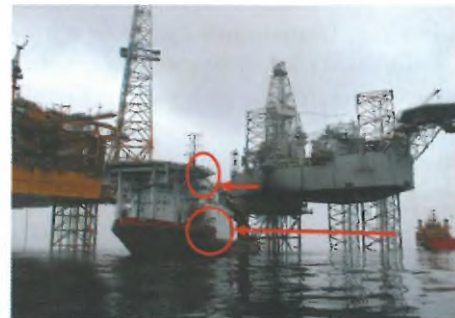
Fot. 1.2. Platforma typu „Jack-up” osłaniająca czujniki siły kierunku wiatru statku utrzymującego się na DP. Źródło 1.
