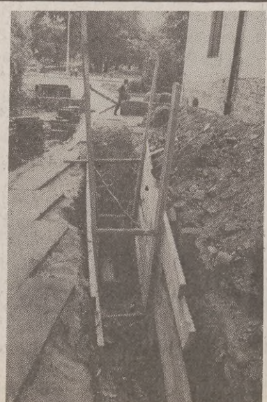
Słupsk. Wbrew pozorom nie są to prace fortyfikacyjne wokół Zamku Książąt Pomorskich, lecz zakładanie instalacji przeciwdeszczowej. Dotychczasowy jej brak powodował nasiąkanie tynku, a co za tym idzie potrzebę częstego odnawiania elewacji. (wat)
