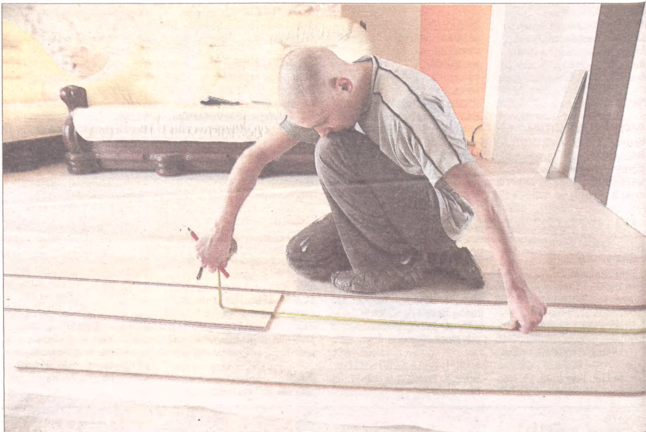
Układanie paneli podłogowych nie jest czynnością zbyt skomplikowaną.
