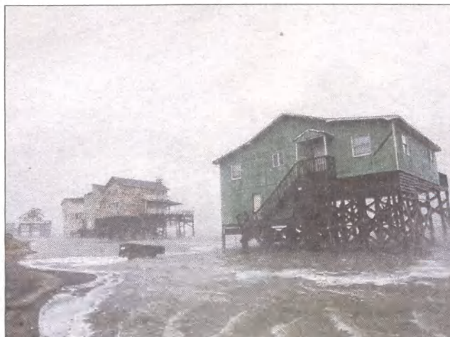
Opuszczone przez ewakuowanych lokatorów domy na plaży w pobliżu Nags Head w Północnej Karolinie.
