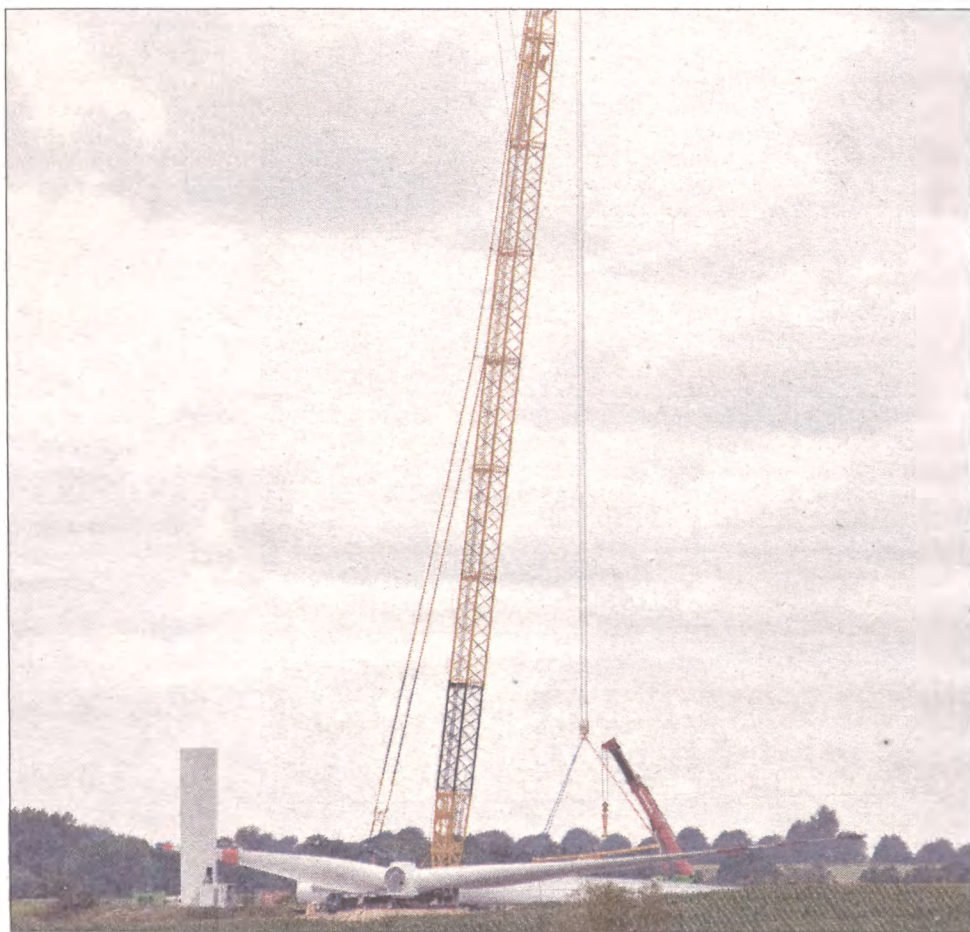
W pobliżu wsi Lulemino trwa właśnie montaż pierwszych turbin wiatrowych dostarczonych tam przez koncern Siemens.
