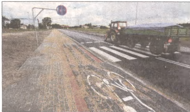
Rok temu nawierzchnię ulicy Żeromskiego stanowiły betonowe płyty, po modernizacji powstała tam ulica z prawdziwego zdarzenia i ze ścieżką rowerową. Fot. Krzysztof Fakman
