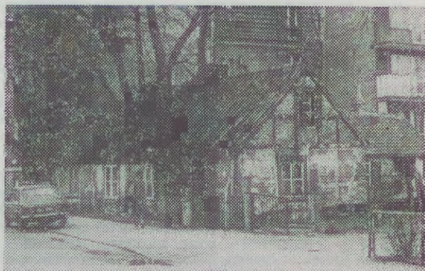
Sopot. Rybacki dom konstrukcji szkieletowej z 1 poł. XIX w. przy ul. B. Chrobrego 34.
