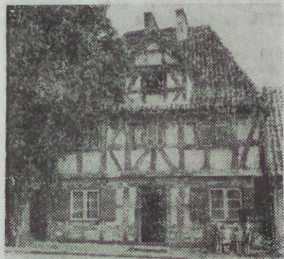
Puck. Ryglowy budynek dawnego szpitala z ok. 1725 r., po renowacji siedziba Muzeum Ziemi Puckiej (ul. Wałowa 11). Stan z 1958 r.
