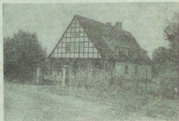
Elganowo. Dom podcieniowy. Fot. E. F. Kozłowski
