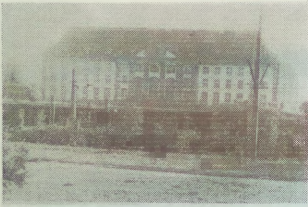
Gdańsk. Budynek Dyrekcji Kolei (stan 1988). Fot. J. Zurawski
