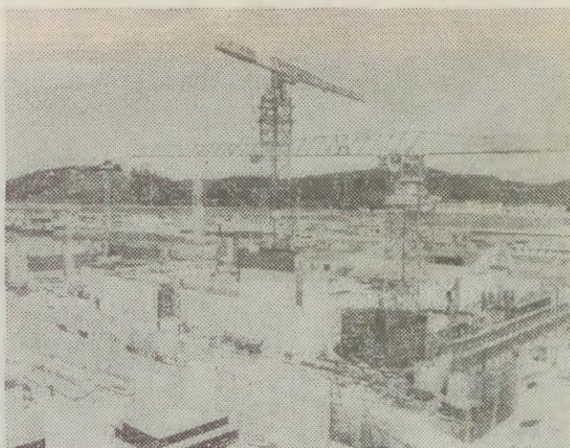
Widok na budynek reaktorowni Elektrowni Jądrowej „Żarnowiec” (w dalszej perspektywie bloki administracyjne). Fot. S. Wiesiołowski
