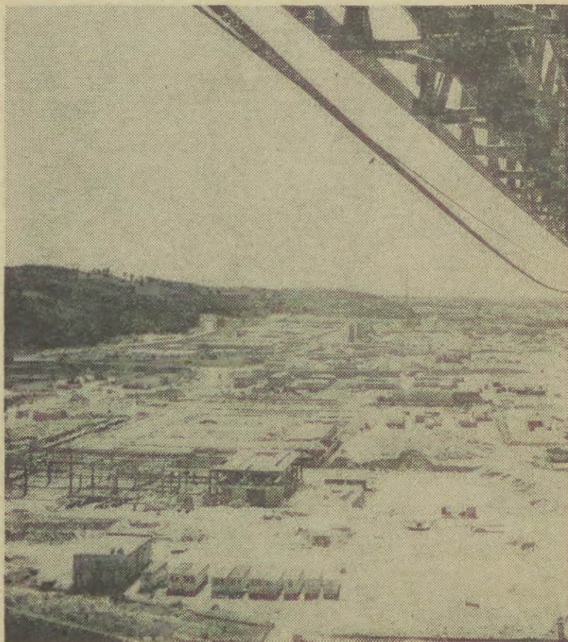
Widok na zaplecze budowy Elektrowni Jądrowej „Żarnowiec”.
