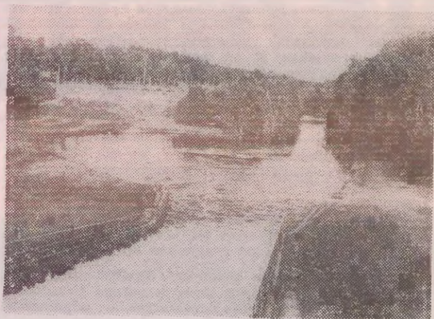
Fragment zapory w Mylofie (na dalszym z lewej — Zakład Hodowli Pstrąga).
