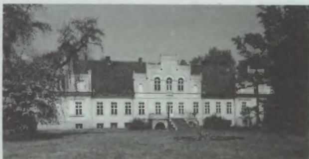
Pałac Przebendowskich w Wejherowie (stan obecny)
