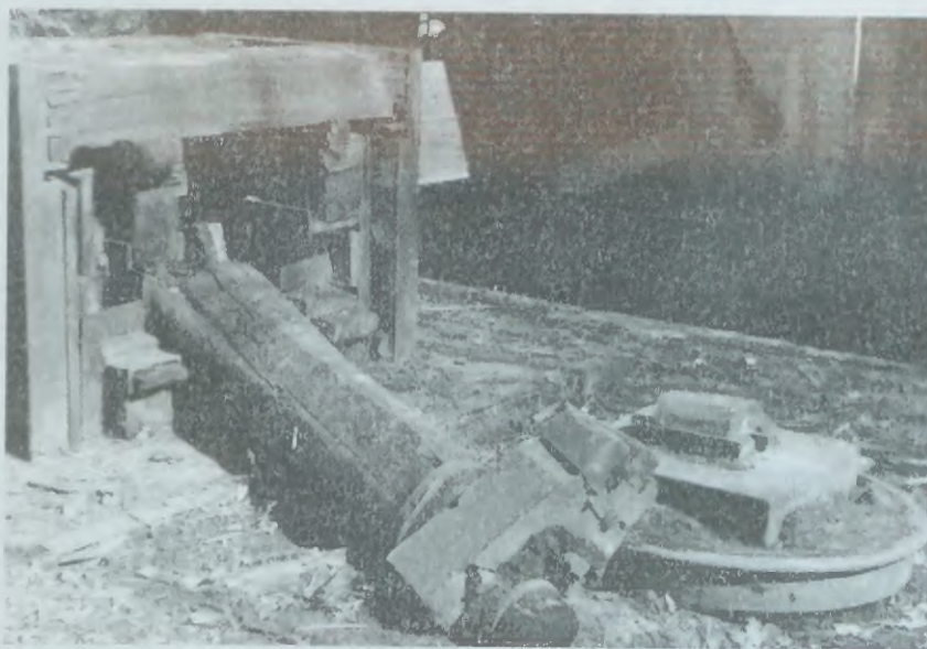
Wnętrze zabytkowej Kuźni Wodnej w Gdańsku-Oliwie przed rekonstrukcją
