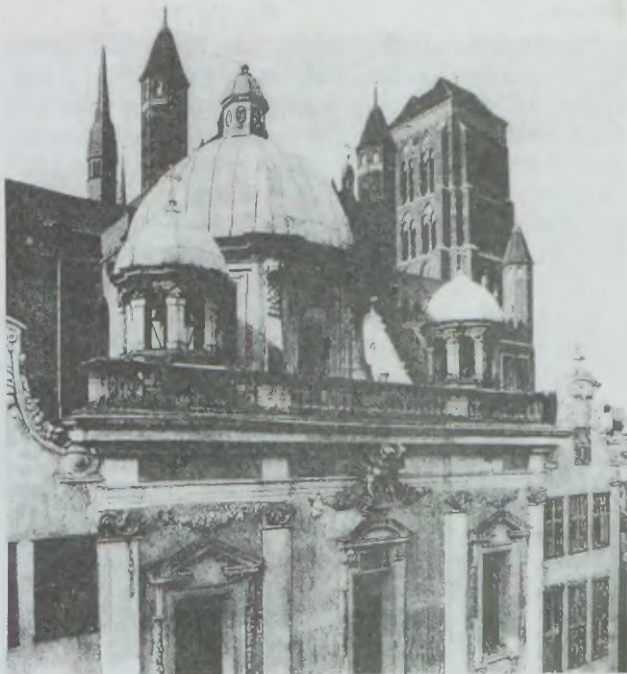
Gdańsk. Kaplica Królewska (stan przed 1945 r.)
