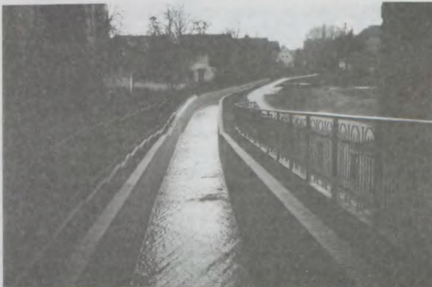
Gdańsk - Wrzeszcz. Odnowiona obudowa koryta Strzyży pomiędzy ul. Wyspiańskiego i Mierosławskiego
