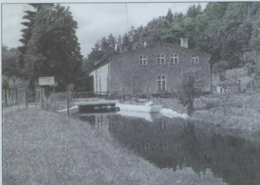
Kanał i siłownia elektrowni wodnej w Skarszowie Dolnym
