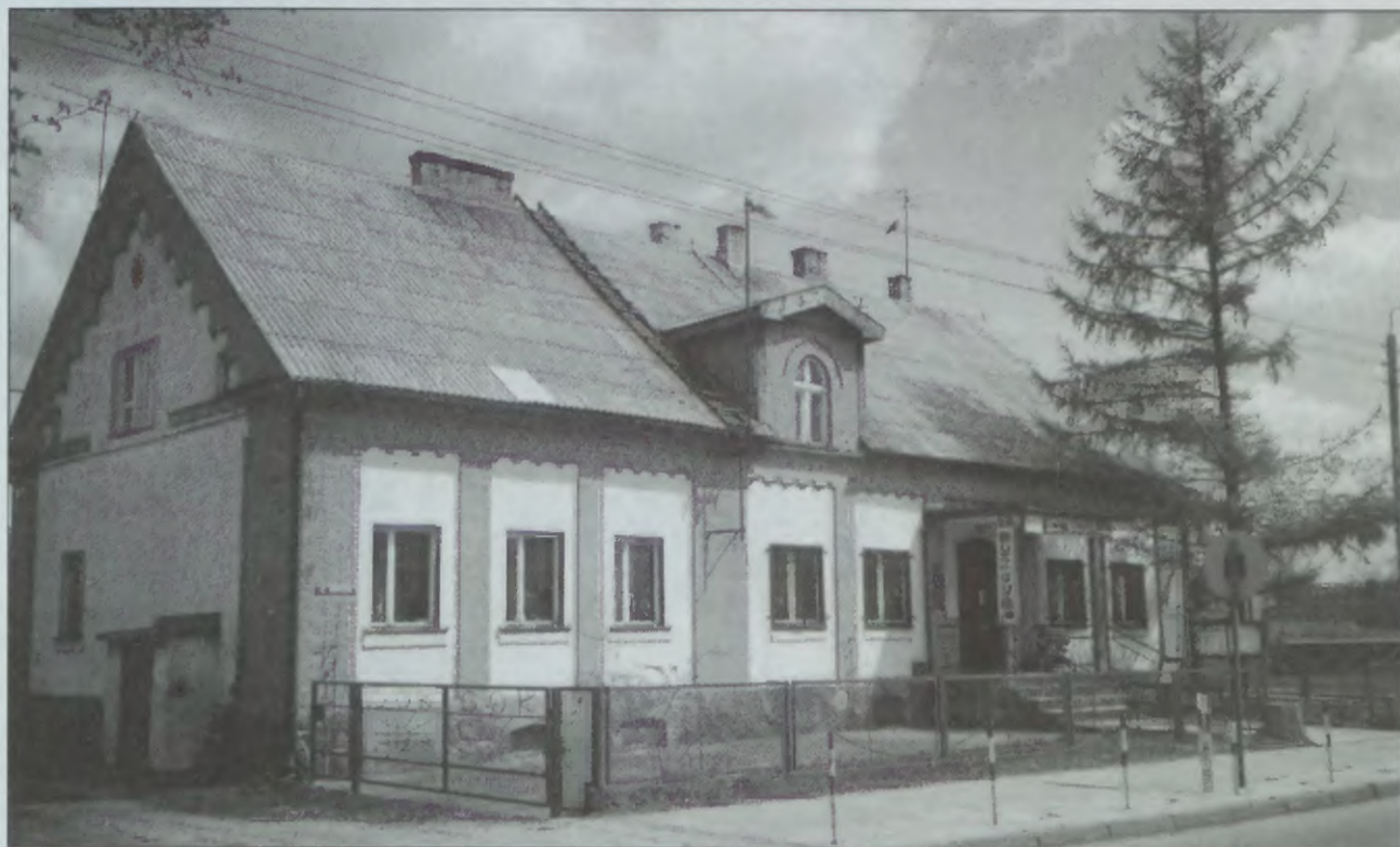
Budynek gminnego Ośrodka Kultury w Sierakowicach
