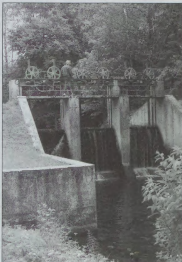
Elektrownia wodna w Skarszowie Dolnym. Jaz na kanale Skotawy
