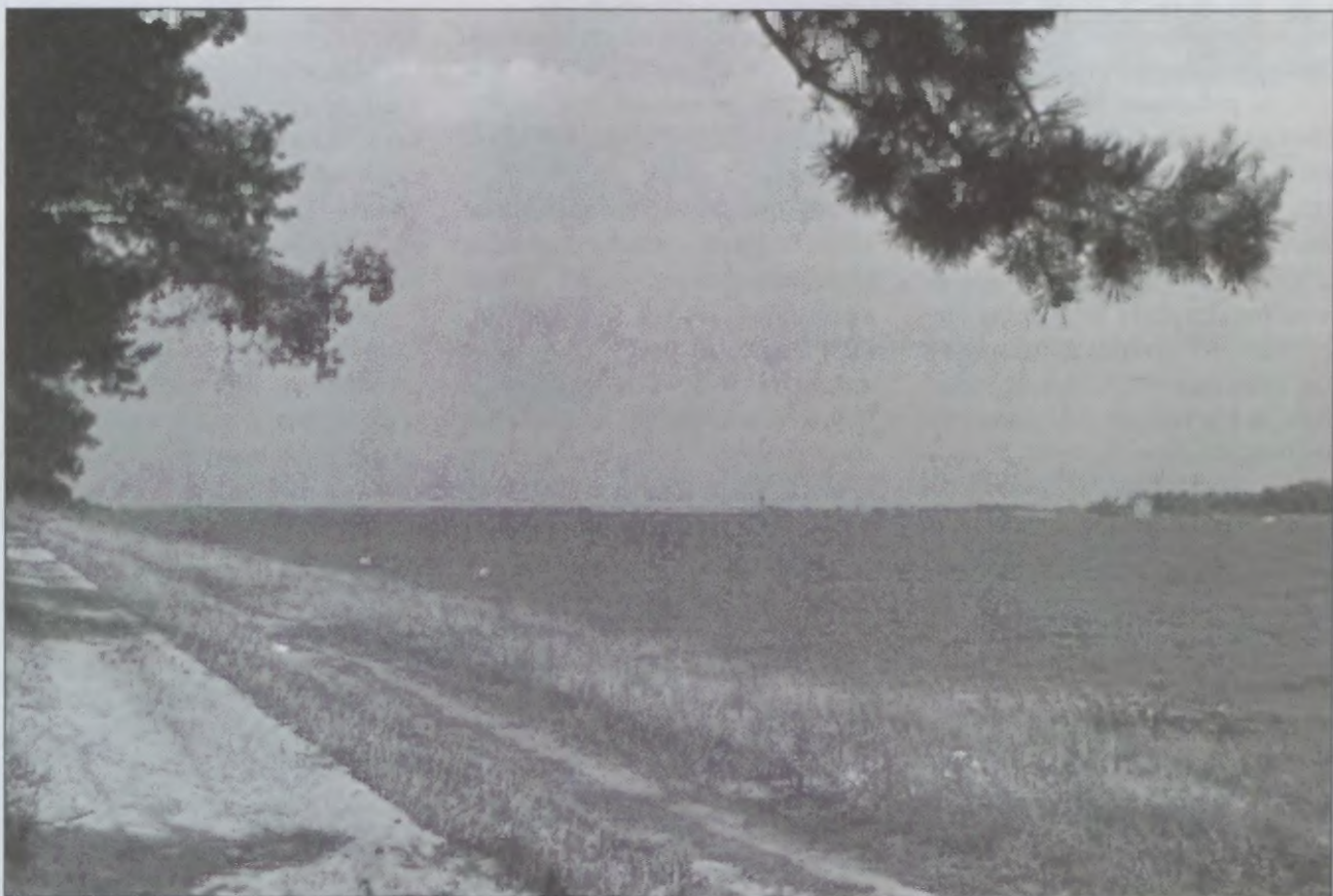
Przekop Wisły pod Świbnem
