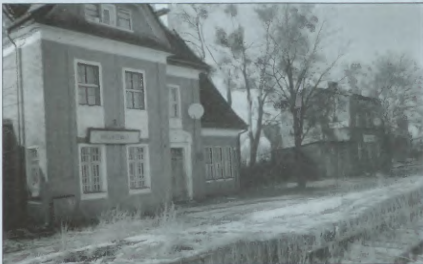
Dworzec kolejowy w Bielkówku
