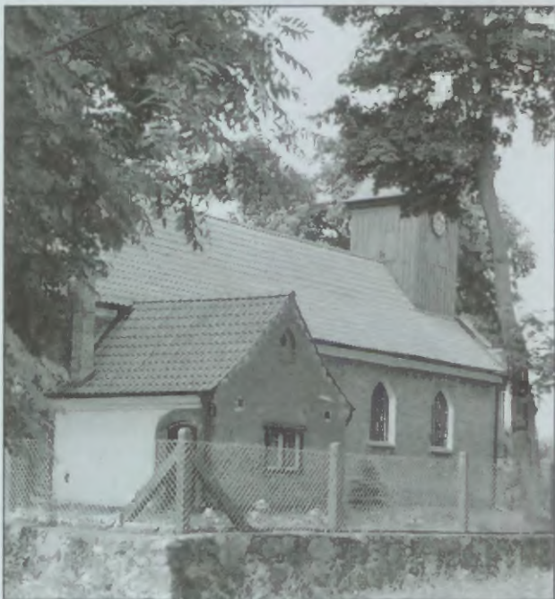
Kościół NMP w Lublewie (widok od strony północnej)
