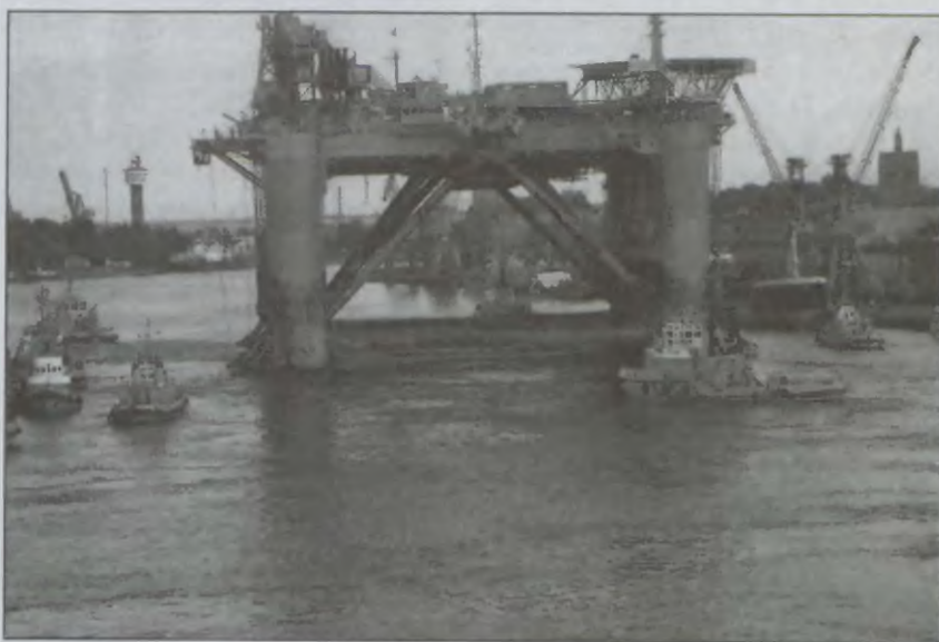
Zespół holowniczy wprowadzający platformę wiertniczą do remontu w stocznia
