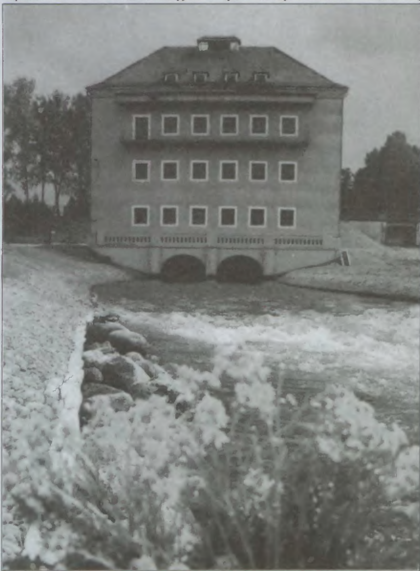
Elektrownia wodna w Krzyni
