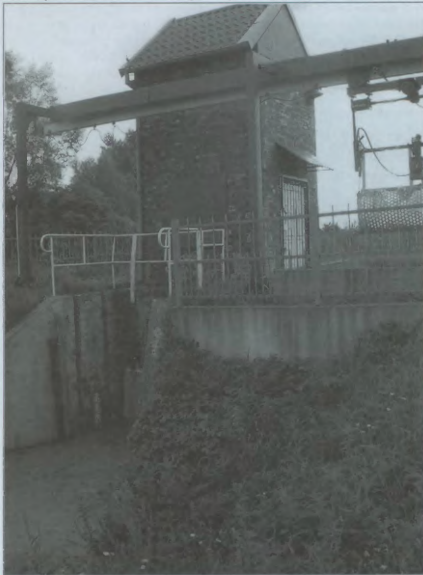
Stacja Pomp Wikrowo. Widok od strony kanału pompowego
