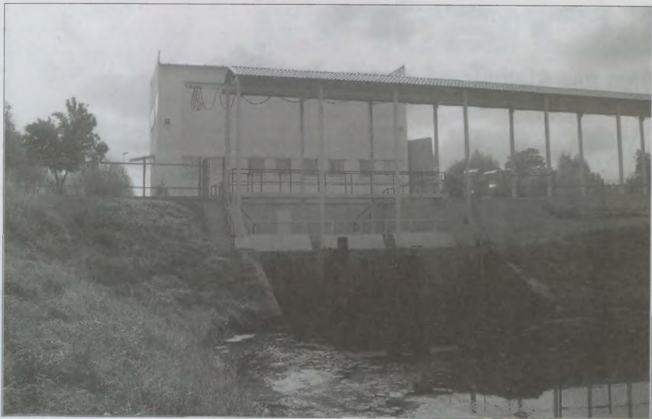
Pompownia Fiszewka F. Widok od strony kanału pompowego
