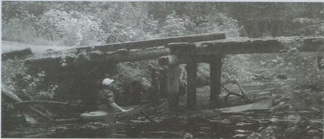
Ostatni most na Czernicy przed ujściem do Gwdy
