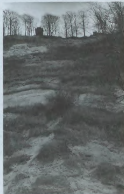
Gosań. Wieża u krawędzi klifu
