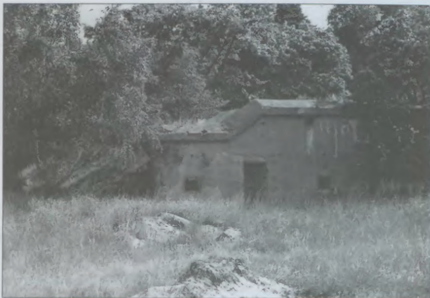
Bateria wydмова. Prawy schron amunicyjno-załogowy
