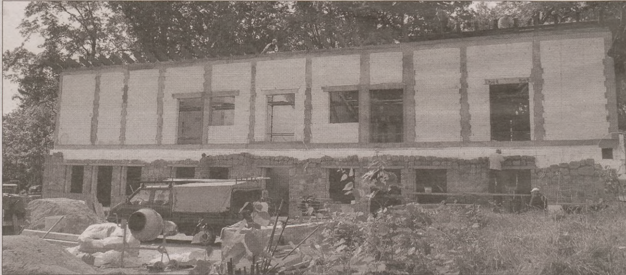
Budowa nowego muzeum w Płotowie.
