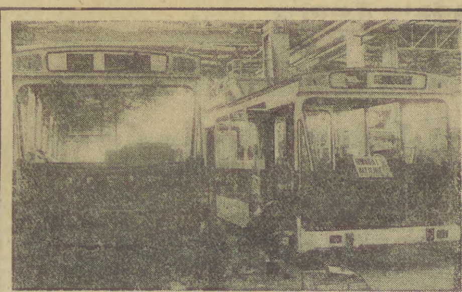
W Jelczaniskich Zakładach Samochodowych przystąpiono do produkcji kolejnego autobusu miejskiego na licencji francuskiej Jelcz-Berliet PR 110. Różni się on od PR-100 tym, że jest pojemniejszy o 10 miejsc, posiada trzy drzwi — co ułatwia wsiadanie i wysiadanie. Do montażu stosuje się zespoły wytwarzane w kraju m. in. silniki z Mielska, skrzynię przekładniową z Tczewa, amortyzatory z Krosna itp. Do końca roku przystąpią się 100 takich autobusów. Na zdjęciu: montaż autobusów. CAF — Wołosztrak
