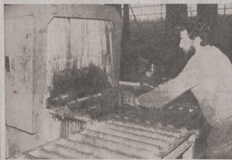
ZNMR w Słupsku jest jedynym w kraju producentem pomp próżniowych do wozów asenizacyjnych. Tutaj wykonuje się także ich remonty. Na zdjęciu: Jerzy Wojciechowski przygotowuje wirniki kompresorów do mycia tunelowego. (bz)
