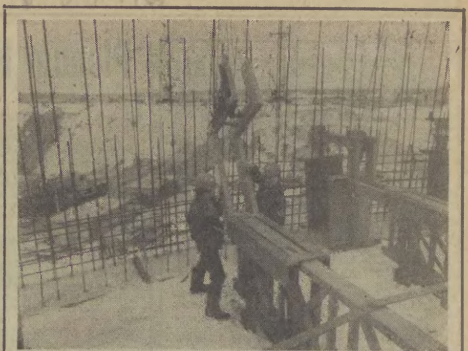
Meldunek z budowy „BELCHATOWA”. Mimo trudnych warunków atmosferycznych w Elektrowni „BELCHATÓW” prowadzone są prace przy wzniesieniu kolejnej inwestycji polskiej energetyki. Główne roboty koncentrują się w obrębie budynku głównej elektrowni, gdzie wykonuje się montaż konstrukcji i prace fundamentowe. Na zdjęciu: Tomasz Popiński i Norbert Kania przy montażu szluzu przeznaczanego do budowy kotłowni. CAF - Zbraniecki - Telefoto
