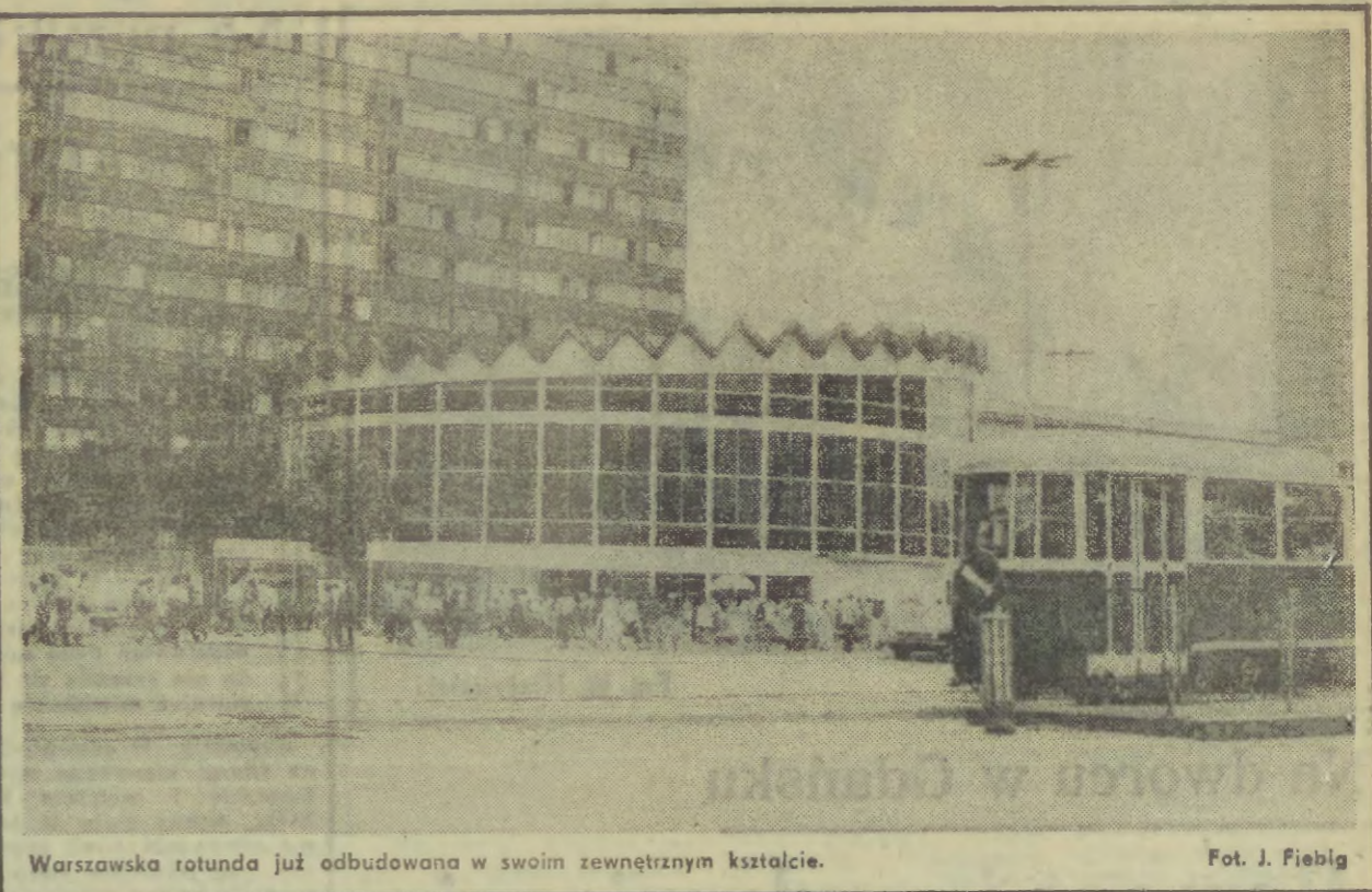
Warszawska rotunda już odbudowana w swoim zewnętrznym kształcie. Fot. J. Fiebig
