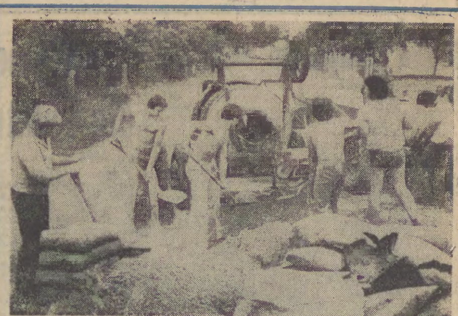
Rolnicy w czynne społeczne. Dla uczczenia 35-lecia Polski Ludowej mieszkańcy Mechnic (gmina Dąbrowa Niemodlińska) podjęli się budowy w czynne społeczne drogi, której łączna powierzchnia będzie wynosiła 600 m kw. W pracach biorą udział rolnicy i członkowie wiejskiej organizacji ZSMR. Na zdjęciu: mieszkańcy Mechnic przy budowie drogi. CAF — Świdzki — Telefoto
