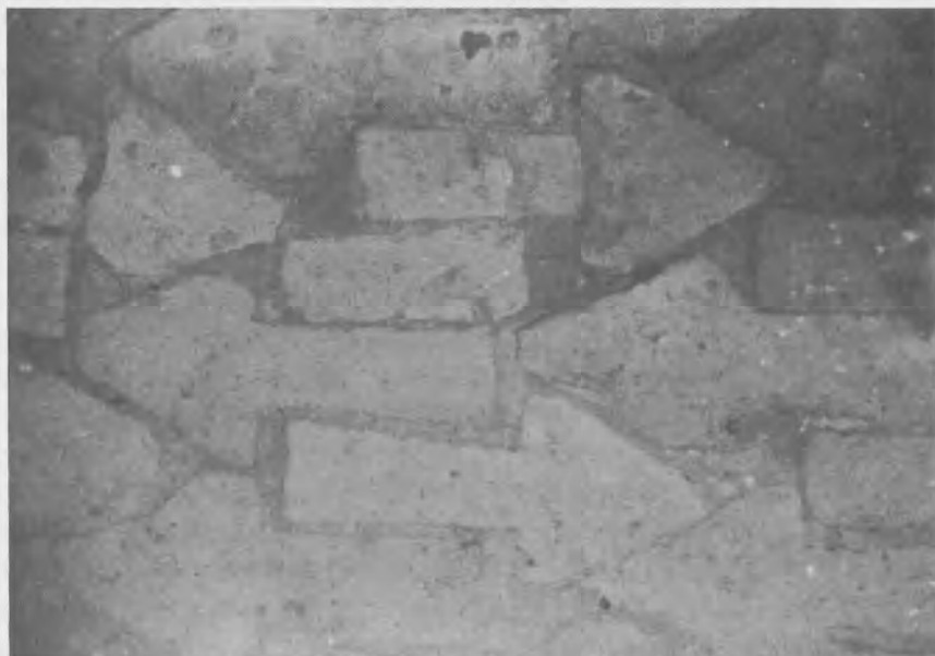
Ryc. 34. Fragment posadzki kościoła w Sławsku wykonanej z gotyckich kształtek ceglanych
