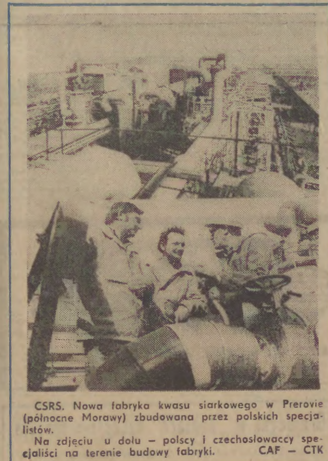
CSRS. Nowa fabryka kwasu siarkowego w Perowie (północne Morawy) budowana przez polskich specjalistów. Na zdjęciu u dołu - polscy i czeskosłowaccy specjaliści na terenie budowy fabryki. CAF - CTK
