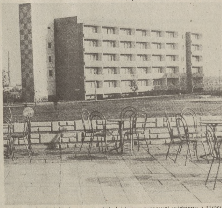
Jeden z budynków koszarowych byłej bazy atomowej widziany z tarasu restauracji „Lipowaj”. W domu tym mieszczą się obecnie pokoje dla wczasowiczów.
