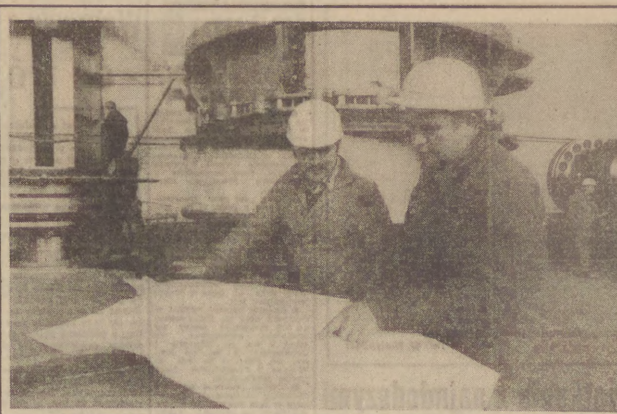
Na budowie elektrowni szczytowo-pompowej nad jeziorem Żarnowieckim roboty prowadzi się na wielu odcinkach. Przy budowni głównym prace wykończeniowe przeprowadzają zalogi „Energobloku Wybrzeże” i gdańskiego „Mostostali”. Wewnątrz hali montuje się dwie turbiny (nr 3 i 4), dostarczone z Czechosłowacji oraz jeden generator (nr 4), wyprodukowany w Związku Radzieckim. Całością robót montażowych, wykonanych przez „Energomontaż Północ” z Gdańska kieruje inż. Witold Dąbrowski. W budynku słowni prowadzi się równocześnie różnorodną pracę elektryczną — instaluje m. in. rozdzielnicę transformatorów, podzespoły automatyki i regulacji oraz zakłada kable, których długość wyniesie około 200 kilometrów. Przy montażu urządzeń pomocą służą specjaliści radzieccy i czescy. Na zdjęciu: montaż turbin. CAF — Janusz Uklewski
