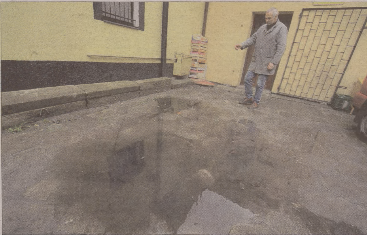
Zalane podwórko przy ulicy Romera w Słupsku. Właściciel sklepu martwi się, że kałuża zamieni się w lodowisko.
