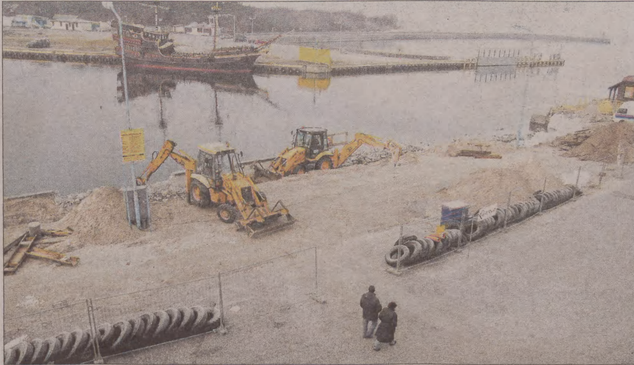
Obecnie w porcie w Ustce trwa przebudowa nabrzeża kołobrzeskiego.
