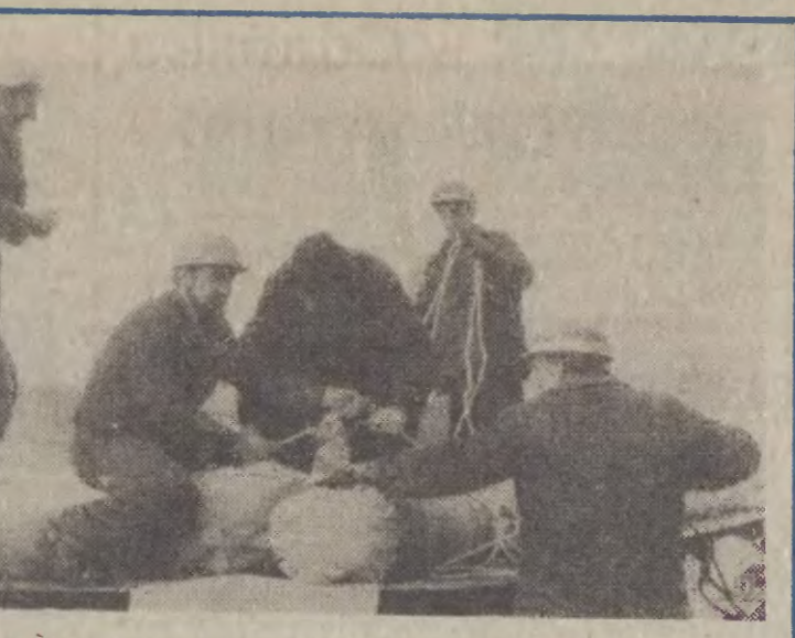
W Stoczni Gdańskiej im. Komuny Paryskiej trwają prace przy uścieleniu zatopionego słatku masowca 35 tys. ton. Polskie Rolnictwo Okręgowe Przytępiło do końcowej pracy założenia plastra na wyrwę w burcie statku. Akcją ratowniczą kieruje Jan Dakzewicz. Na zdjęciu: stocznicy; w tle Stanisław Nowak przygotowujący plastry awaryjne przed założeniem na burłę statku. CAF — J. Uklejewski — Telefot
