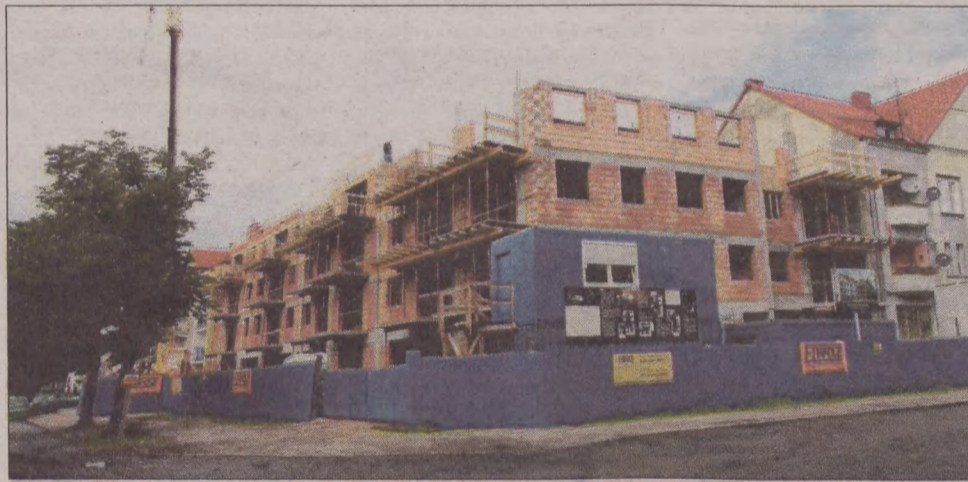
Trwają prace przy trzecim, przedostatnim piętrze Kamienicy Warszawskiej w Lęborku. Jeszcze do końca roku ta inwestycja ma osiągnąć stan surowy.
