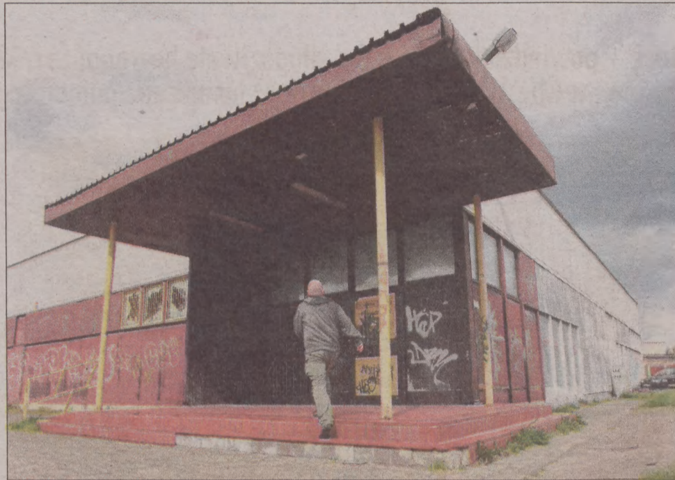
Ten zrujnowany dawny market na ulicy Teligi przyciąga młodzież i jest coraz częściej demolowany. Obok jest mnóstwo rozbitego szkła i wystająca blacha, którą można sobie zrobić krzywdę – mówią mieszkańcy osiedla Sportowe w Lęborku.
