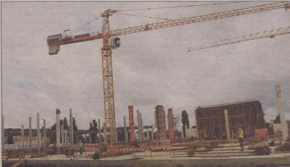
Prace przy rozbudowie CH Jantar są prowadzone w ekspresowym tempie.
