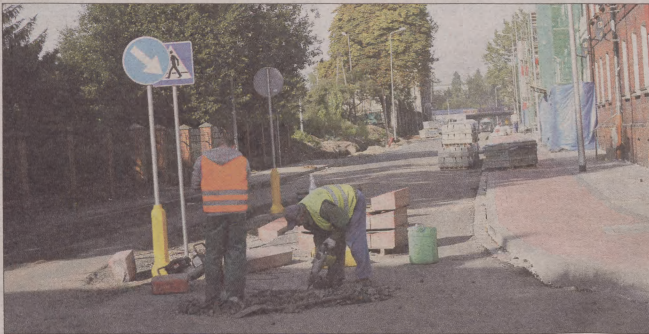
Remont ulicy Poniatowskiego jest już niemal zakończony.
